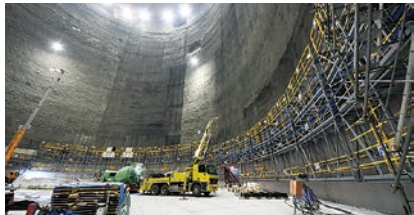
建設中のハイパーカミオカンデの水槽 (写真:東京大学宇宙線研究所 神岡宇宙素粒子研究施設)
