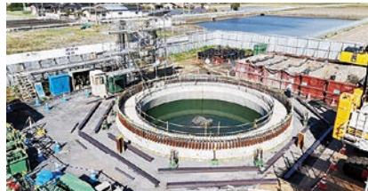
J-PARCから約1km離れたところで生成直後のニュートリノを観測するための中間検出器を建設中
