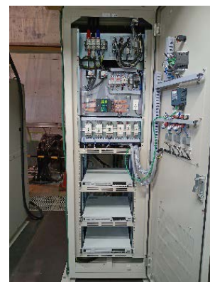
図 2. 2024 年に設置された 3 in 1 電源。電磁石 3 台分の SW 電源が 1 つの筐体に収納されている。
