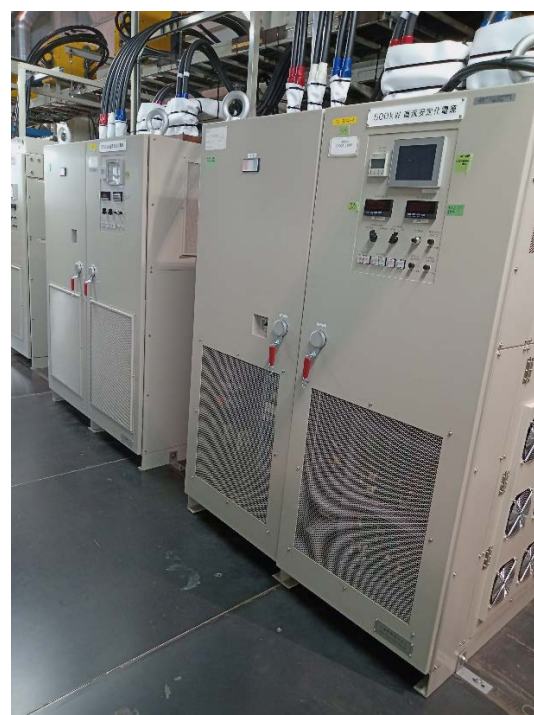
図 3. 入替作業後の 500 kW THY 電源 2 台 (電磁石負荷 140V-4800A)
