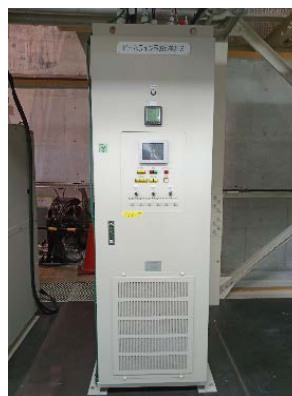
図 2. 2024 年に設置された 3 in 1 電源。電磁石 3 台分の SW 電源が 1 つの筐体に収納されている。
