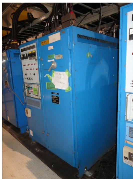
図 1. ハドロン実験施設で使用されていた 1973 年頃製造の 500 kW 直流安定化電源 (出力定格 100V-5000A)
