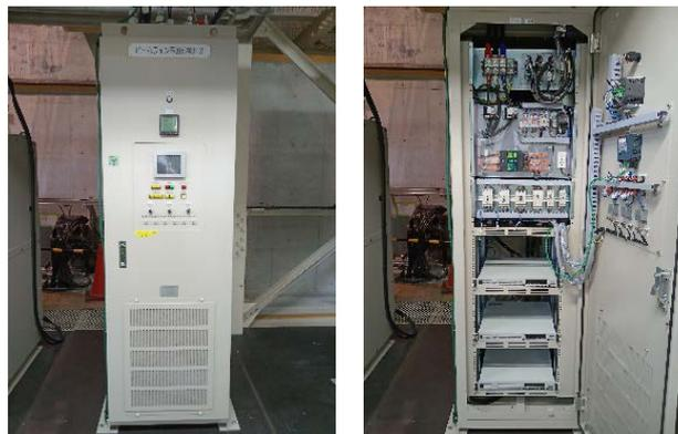
図 2. 2024 年に設置された 3 in 1 電源。電磁石 3 台分の SW 電源が 1 つの筐体に収納されている。
