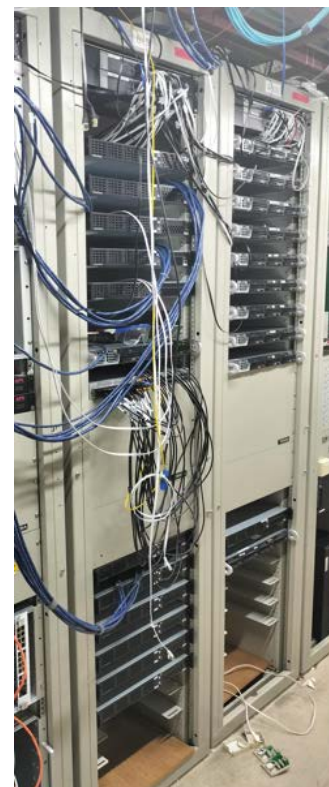
図 2. 刷新後の読み出しシステム。2 台のラックに 21 台のサーバを収納。
