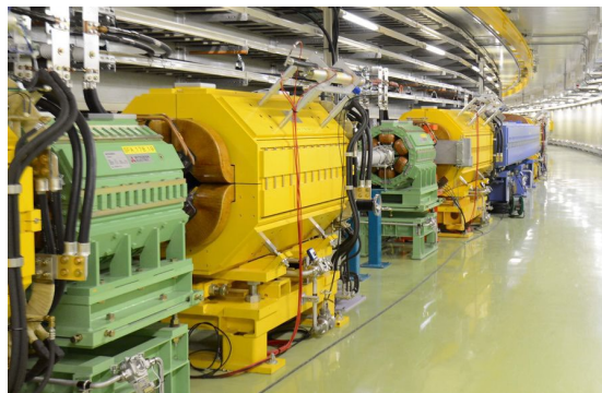
J-PARCのメインリングの電磁石の一部
