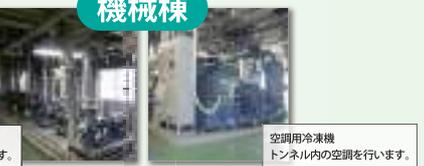
実験冷却水ポンプ 電磁石の冷却を行います。
