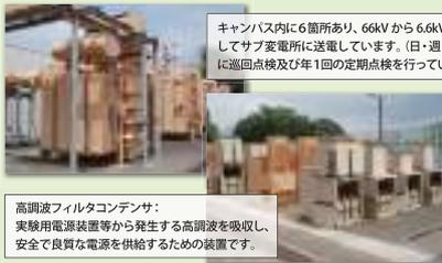
キャンパス内に6箇所あり、66kVから6.6kVに変換してサブ変電所に送電しています。(日・週・月ごとに巡回点検及び年1回の定期点検を行っています。)
