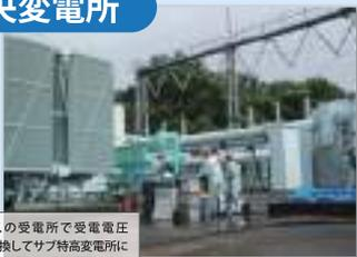
つくばキャンパスの受電所で受電電圧154kVを66kVに変換してサブ特高変電所に送電しています。(日・週・月ごとに巡回点検及び年1回の定期点検を行っています。)
