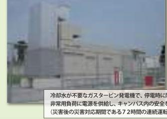
冷却水が不要なガスタービン発電機で、停電時に防災用負荷等の非常用負荷に電源を供給し、キャンパス内の安全を確保します。(災害後の災害対応期間である72時間の連続運転が可能です)
