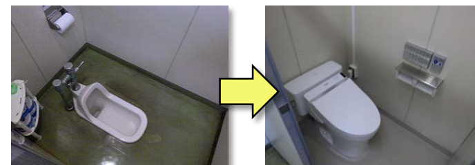
図5.35 和式から洋式トイレ改修
