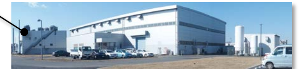
図4.29 超伝導リニアック試験施設棟 ©KEK
