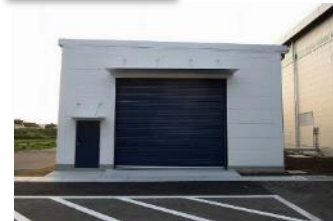
COIコンプレッサー棟(H28)
