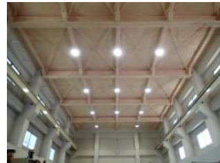
特定天井3棟耐震改修(R1)
