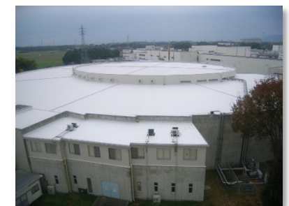
図4.8 PF光源棟部分改修
