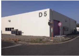
MR第4~6電源棟(H29)
