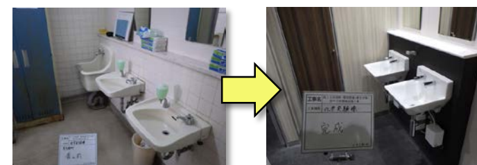
図5.36 洗面所の自動水栓化
