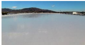
ATF屋上防水(H29)
