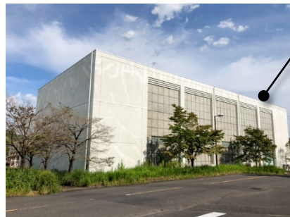
図4.27 先端計測実験棟
