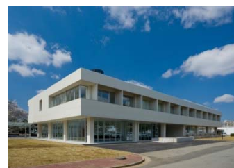
図2-14 省エネルギー改修（1号館改修）の事例（屋上緑化・ルーバー・人感センサー・高効率照明・高効率空調等）
