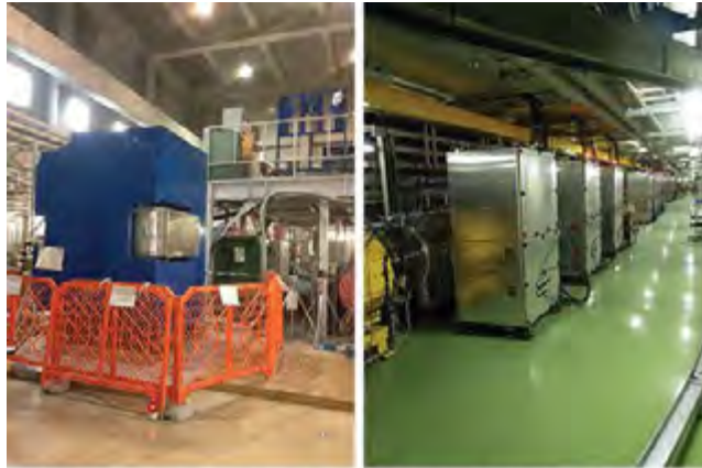
J-PARCニュートリノモニター機で試験中だった磁場中熱処理炉。後日、日立金属での量産に用いられた。
