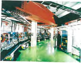
先端加速器試験棟 (ATF)
