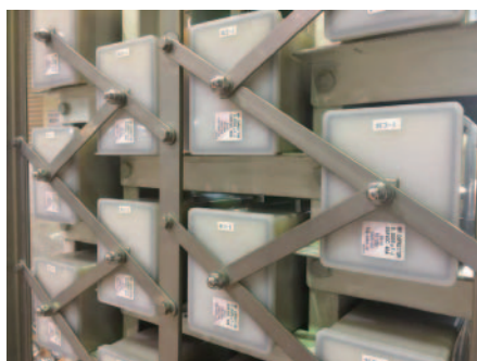
図2. 火災前に使用されたものと同型のコンデンサ
