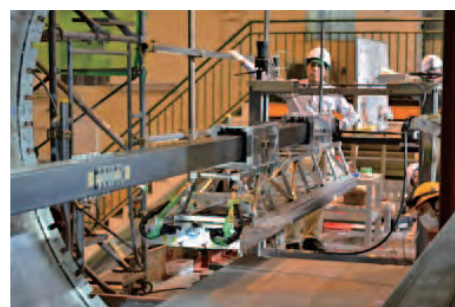
図 2. TOP カウンターインストールの様子。長いビームにぶら下げられているのがストロングバックに取り付けられた TOP カウンター。
