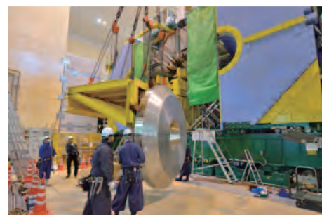
図 4. 後方 ECL 検出器インストールの様子
