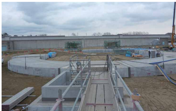
図 7：陽電子ダンピングリングトンネル建設中の様子 (現在はすでに完成)。
