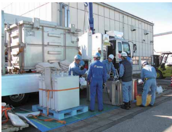
PCB 運搬専用車両への積込作業の様相
