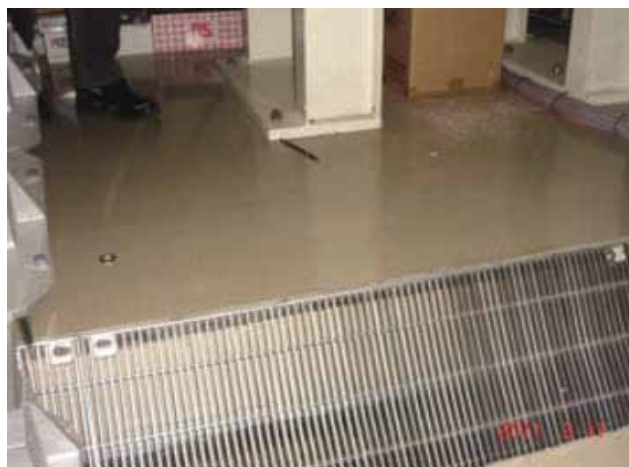
写真5. MLF 実験ホール (奥側) に比べ約 15 cm 沈下した長尺ビームライン建屋 (手前側)
