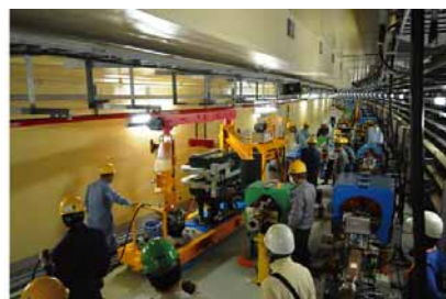
図1.KEKBリングの解体作業
