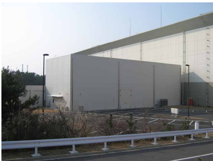
J-PARC/MLF 革新型蓄電池実験棟
