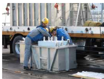
PCB 含有機器の搬出作業の様子
