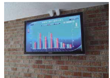
発電設備表示パネル（管理棟）
