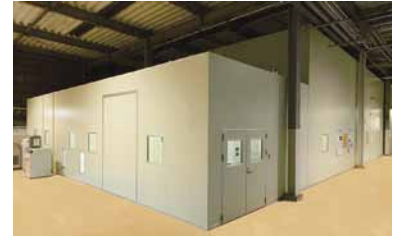
2009年度完成した 超伝導空洞製造技術開発施設
