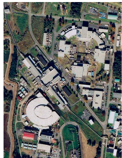
放射光光源棟、PF-AR 実験棟
