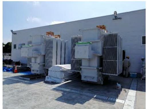
南特高変電所特高受変電設備更新（工事中）
