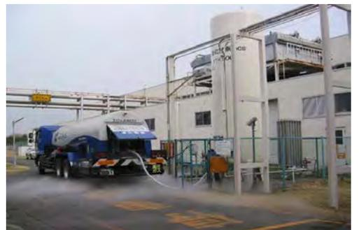
液体窒素をローリー車からタンクに充填している様子
