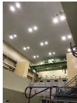
<高天井照明更新>
