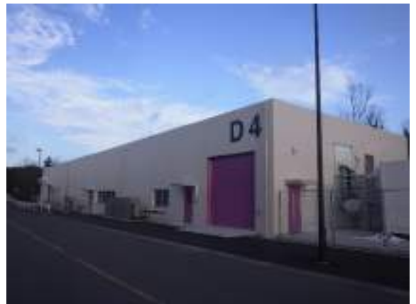
J-PARC ビーム増強施設 (第 4 電源棟)
