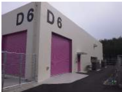
J-PARC ビーム増強施設（第 6 電源棟）
