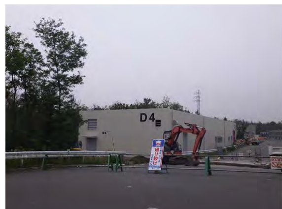
J-PARCビーム増強施設MR第4電源棟(建設中)
