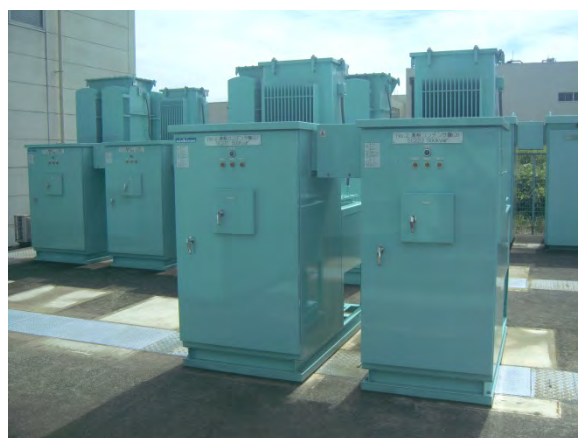
筑波特高変電所コンデンサ更新工事
