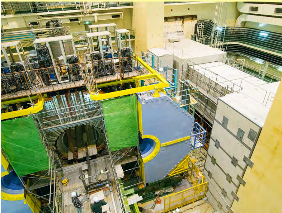
ビームラインが遮蔽体に覆われ（右奥）、2016年2月に試運転を開始したSuperKEKB加速器
