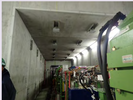
筑波実験棟加速器の衝突点付近のシールド（内部より撮影）
