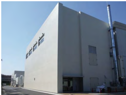
一次陽子ビームラインの新設（ハドロン南実験棟）
