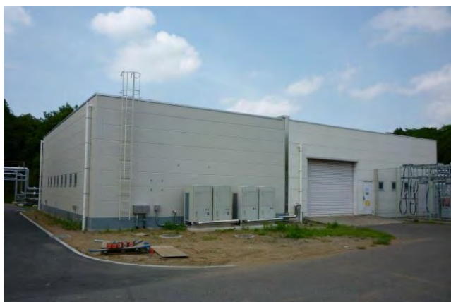
MR・D3電源棟増築（つくばキャンパス）
