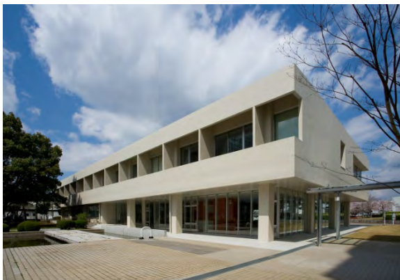
改修工事が終わったつくばキャンパス1号館
