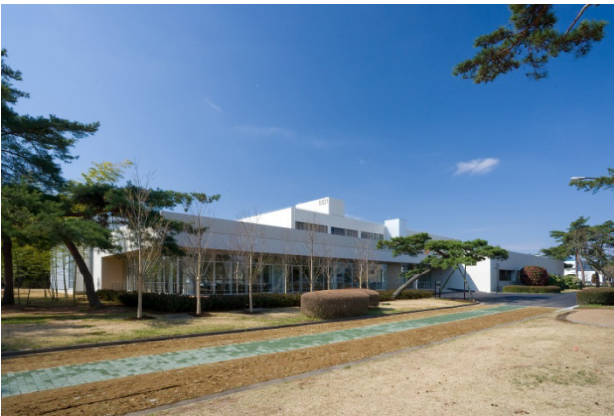
改修工事が終わった研究本館（つくばキャンパス）
