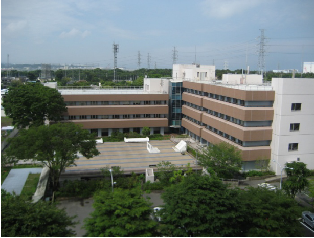
交換契約により取得した土地、建物（写真は改修した東海キャンパス1号館）
