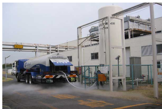
液体窒素をローリー車からタンクに充填している様子
