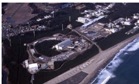
建設が進むJ-PARC(東海キャンパス)
