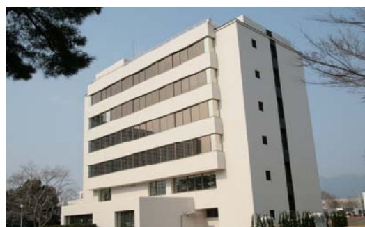
耐震対策が施された2号館(つくばキャンパス)
