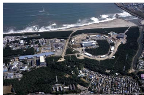
東海キャンパスで建設が進むJ-PARC
