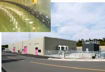
J-PARC 第1電源棟
