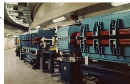
主リングトンネル
