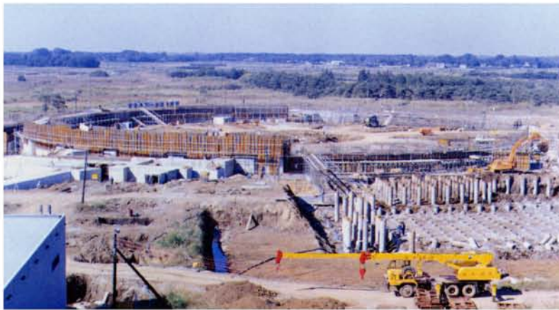
主リング及びカウンターホール建設現場 Construction of the Main Ring and Counter Experimental Hall.
