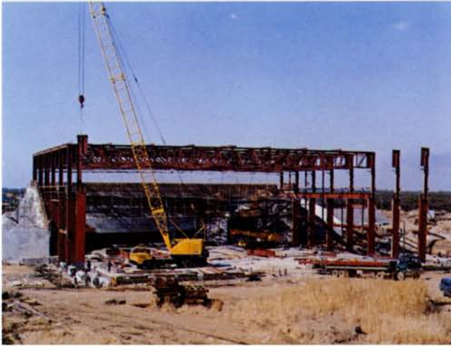
カウンター実験ホール建設工事 Construction of the Counter Experimental Hall.
