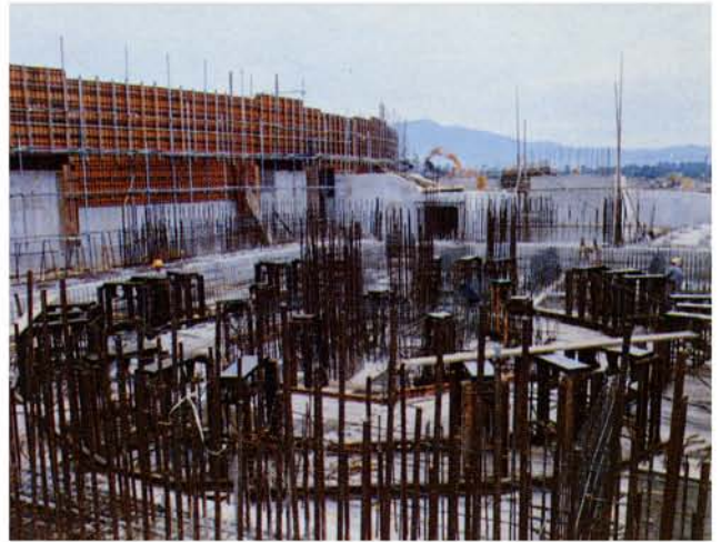
ブースター基礎工事 Groundwork for the Booster accelerator.
