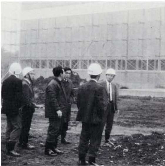
加速器実験室工事 (45年、筑波) Construction work for the accelerator experimental hall (1970, Tsukuba).
