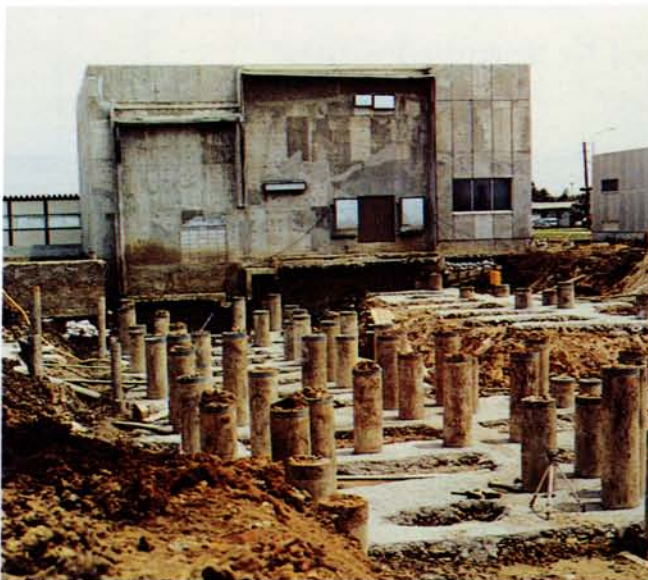
ライナック基礎工事 (後方前段加速器室) Groundwork for the Linear Accelerator.
