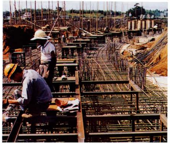
主リングトンネル基礎工事 Groundwork for the Main Ring.
