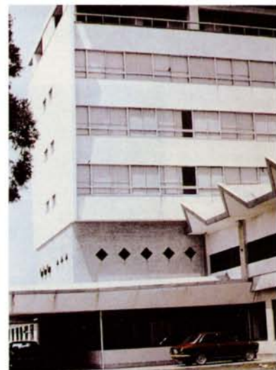
仮庁舎兼職員宿舎 (旧クラブハウス)
