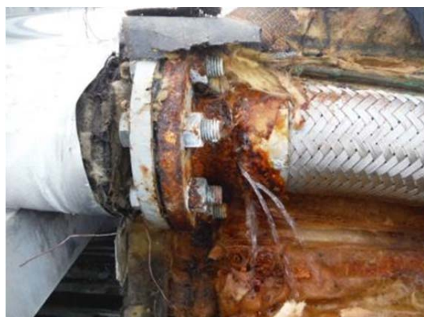
屋外給水管 (上水)
