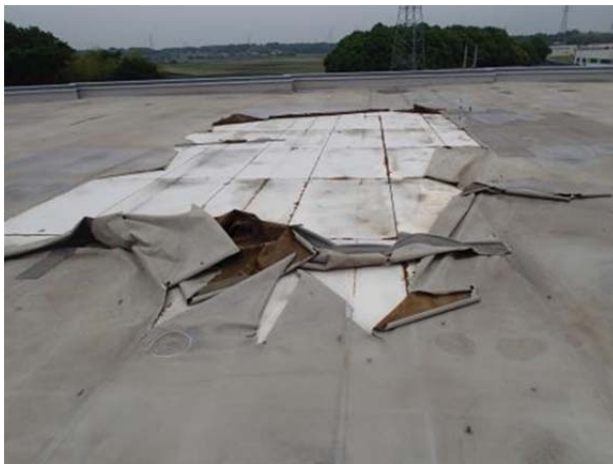
施設の老朽化状況写真（防水層の劣化による破れ）
